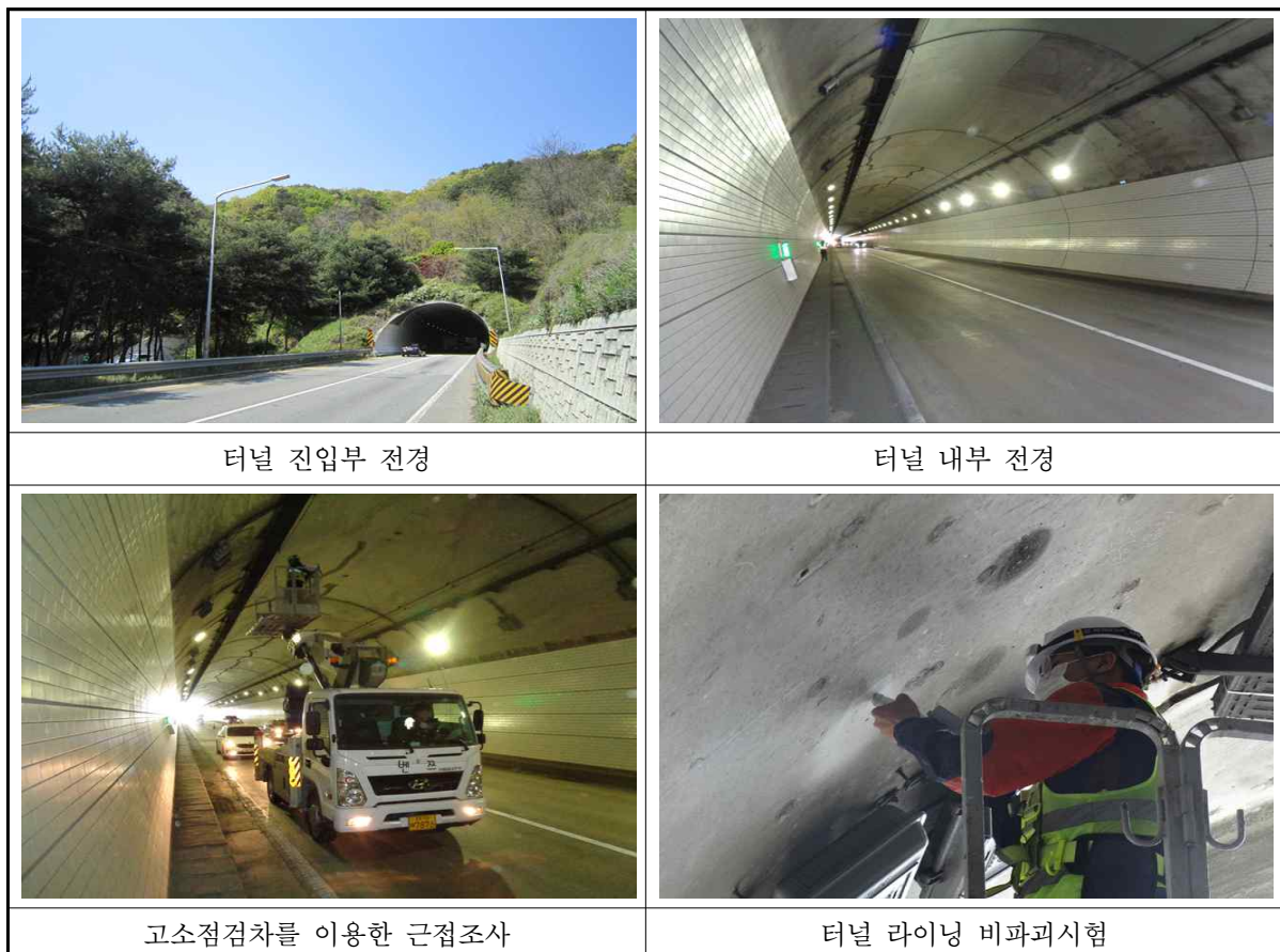
【사진 3.2】 근접조사를 위한 장비 사용 전경
