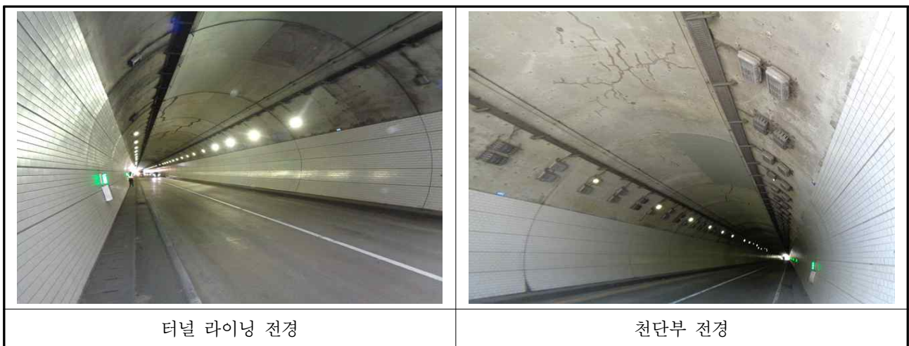
【사진 3.3】 터널 라이닝 천단부 전경
