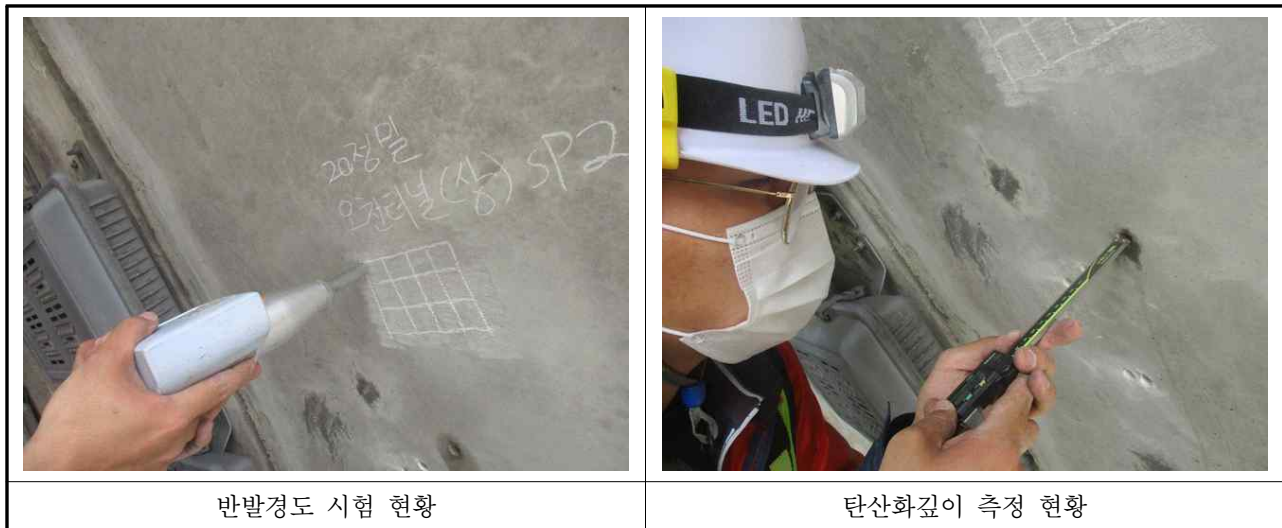
【사진 3.17】 콘크리트 내구성조사 현황
